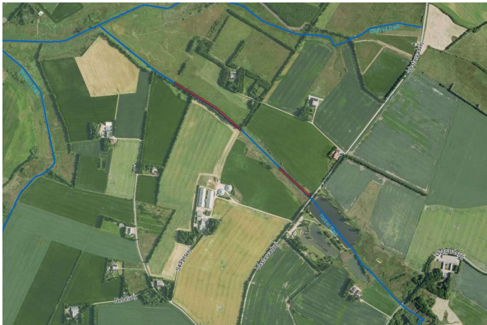
Figur 1. De røde linjer viser projektstrækningerne i Nebel Bæk st. 462-1210. Den røde linje i øverste venstre hjørne viser strækningen med de to slyngninger, og linjen nederst til højre viser strækningen med de tre grusstryg.
