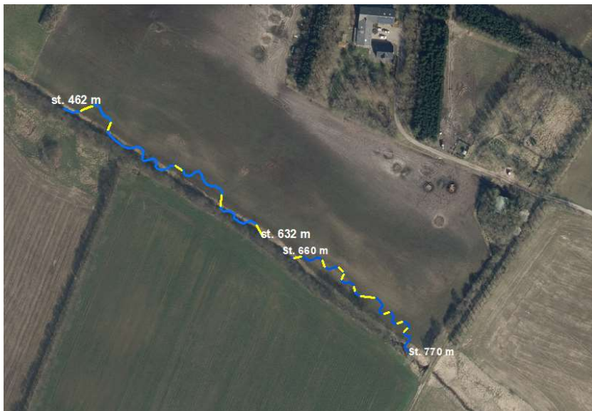
Figur 2. De to genslyngede strækninger mellem st. 660-770 m og st. 462-632 m.
